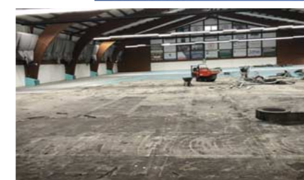
Während der Arbeiten in der Halle.
